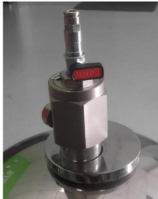
17. Abra lentamente la llave de seguridad de la válvula del cilindro, colocándola en posición vertical. De esta manera se consigue igualar las presiones del tubo y la cámara superior de la válvula de forma progresiva. La instalación queda en servicio.
