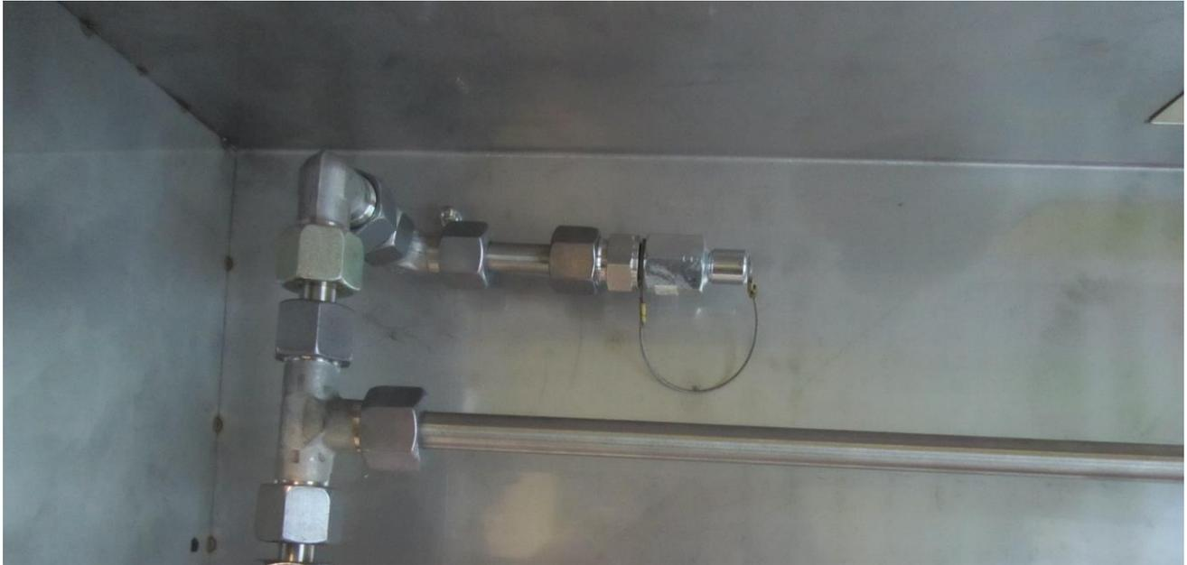
8. En el conjunto se suministra un pasamuros con tapón final para la tubería de extinción, válido para sujetar el final de la tubería a la campana extractora. De esta manera se da rigidez a la tubería.
