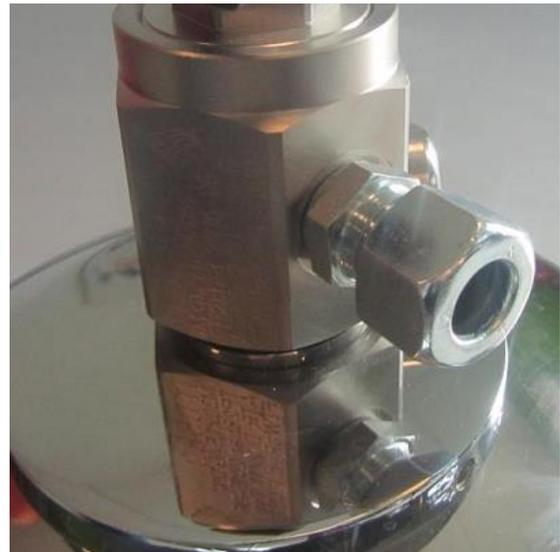
5. Instale el cilindro en la posición deseada utilizando el soporte y brida de sujeción suministrados y realice la instalación de la tubería de extinción
